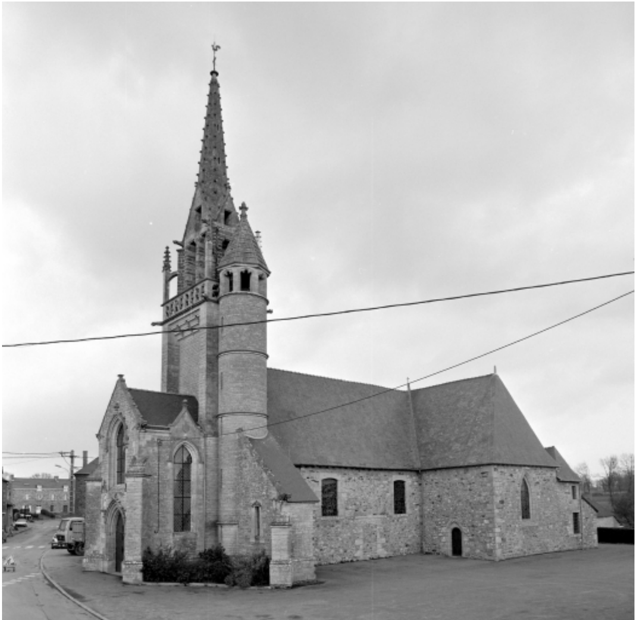
Elévation Sud-Ouest : vue générale
