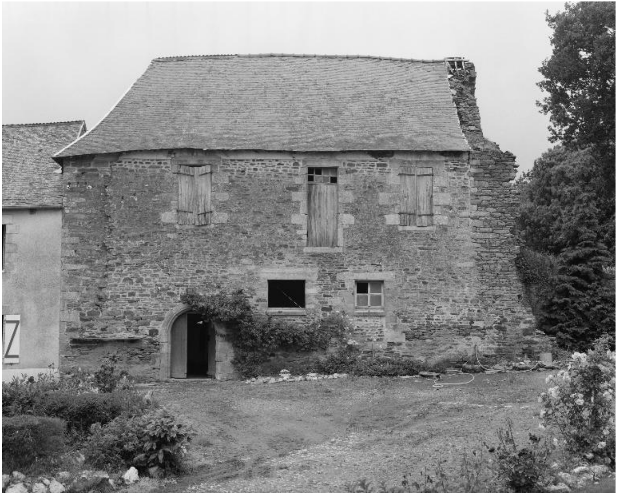
Manoir : élévation sud (état en 1991)
