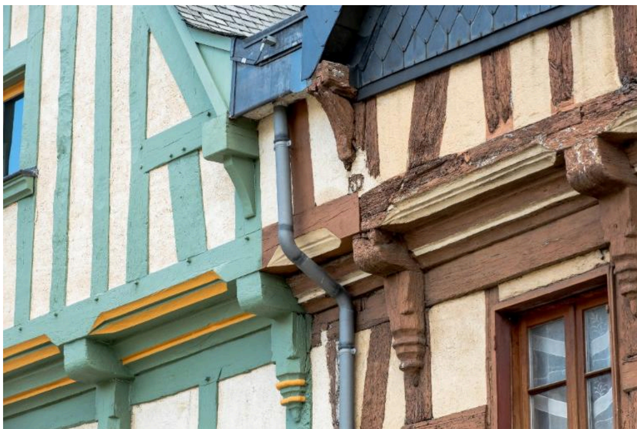
Jonction entre les deux maisons.
