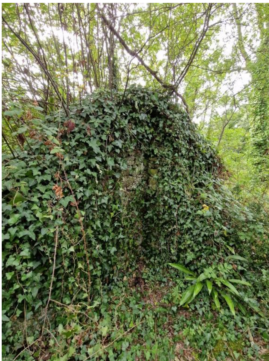
Vue des vestiges : mur en pierre maçonnée
