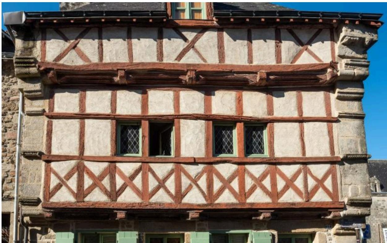
La façade en pan de bois s'ancre dans des gouttereaux maçonnés dont le décor prolonge des éléments structurants (lisses haute et basse, sablières).
