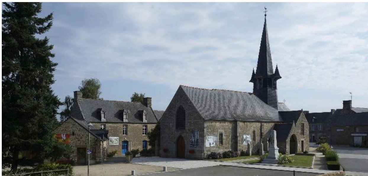
Vue sud-ouest de l'église
