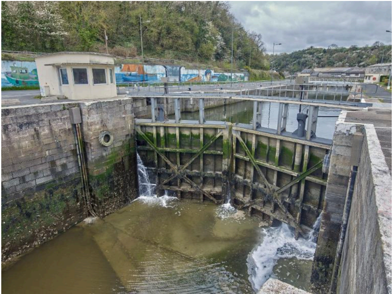
Les portes busquées à deux vantaux (aval)
