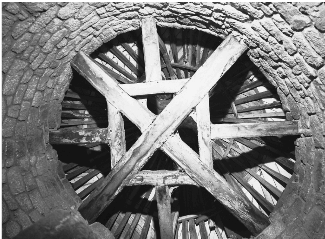
Tour d'escalier : vue générale de la charpente
