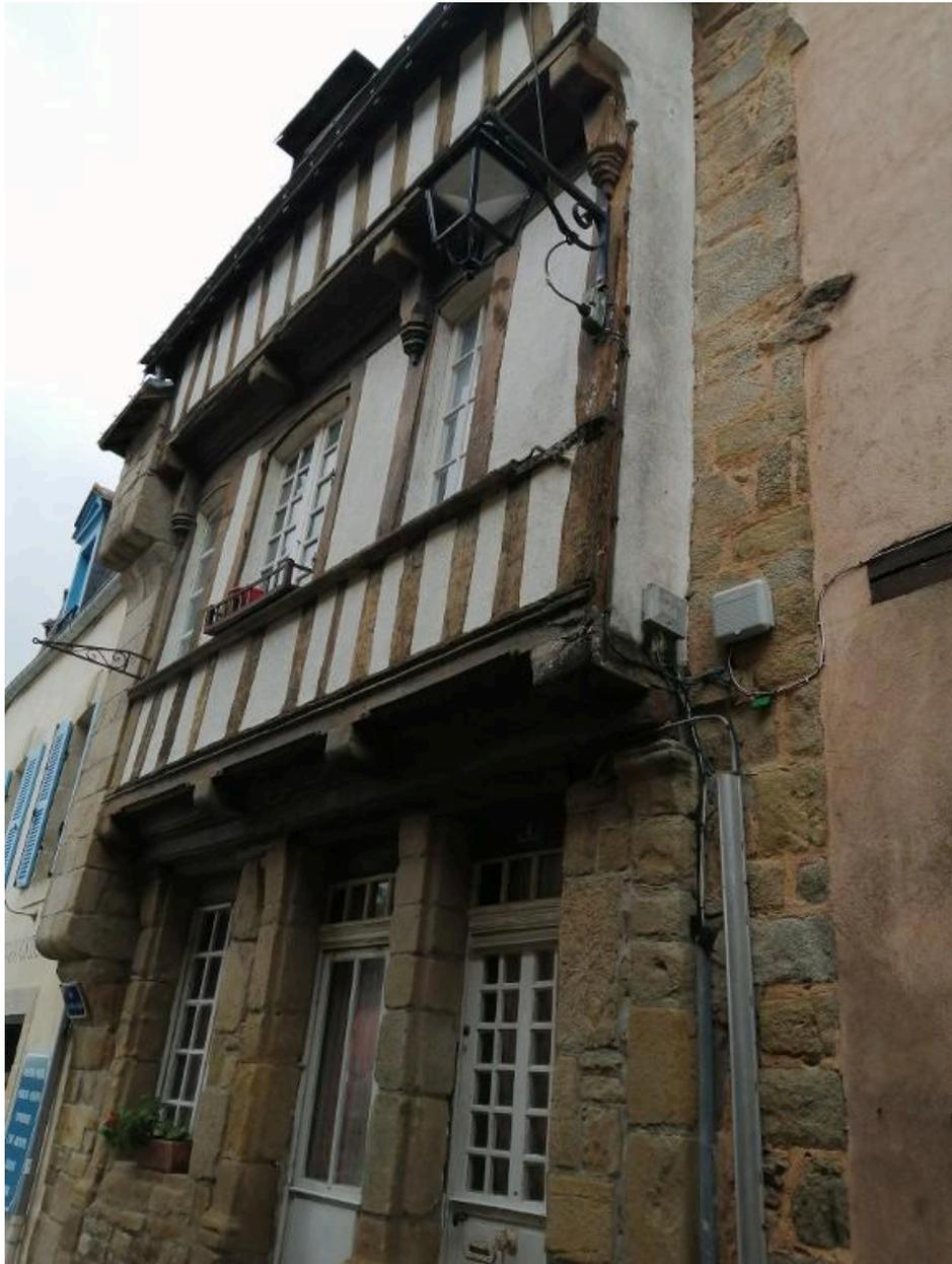
L'étage et le surcroît sont en encorbellement sur solives.
