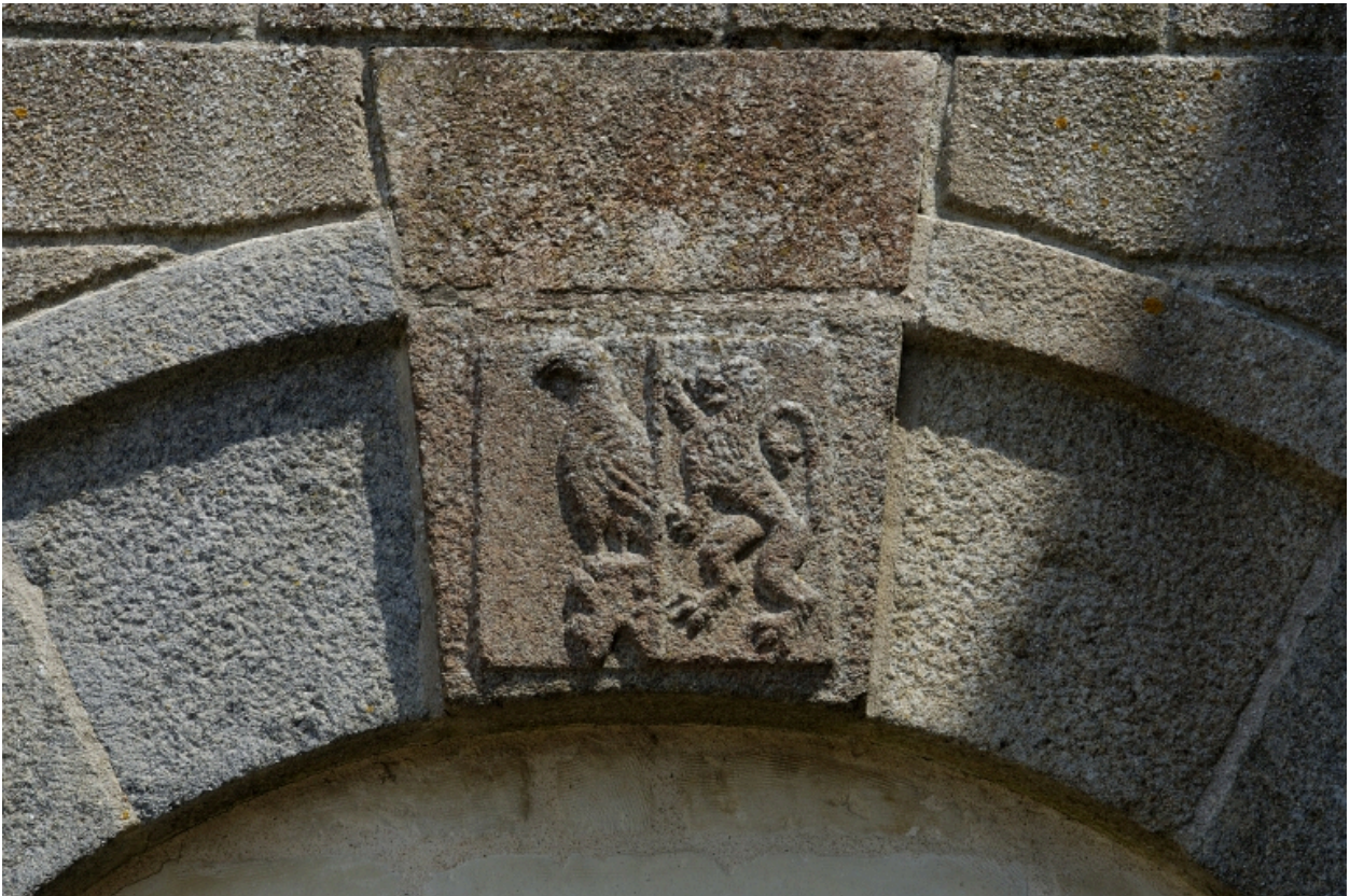
Détail armoirie transept nord
