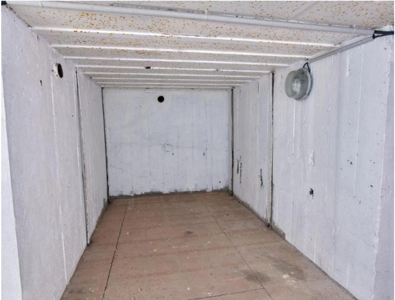
Vue du logement des soldats. Les murs et le plafond conservent les traces de fixations murales et crochets de suspension pour des couchettes tubulaires. Les entrées de tuyau servent au système de ventilation (envoi de l'air vers les chambres de combat)
