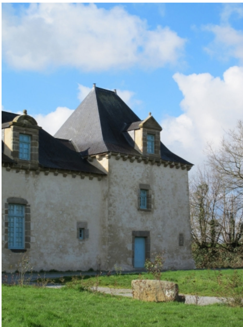
Partie ouest du bâtiment sud-ouest
