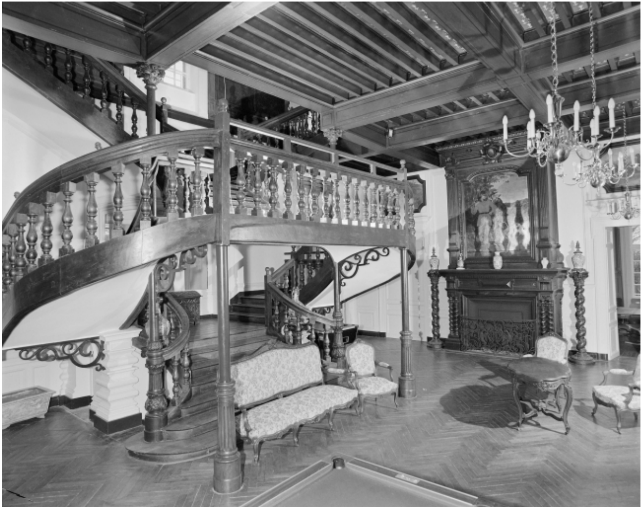
Vue générale du hall d'entrée après restauration.
