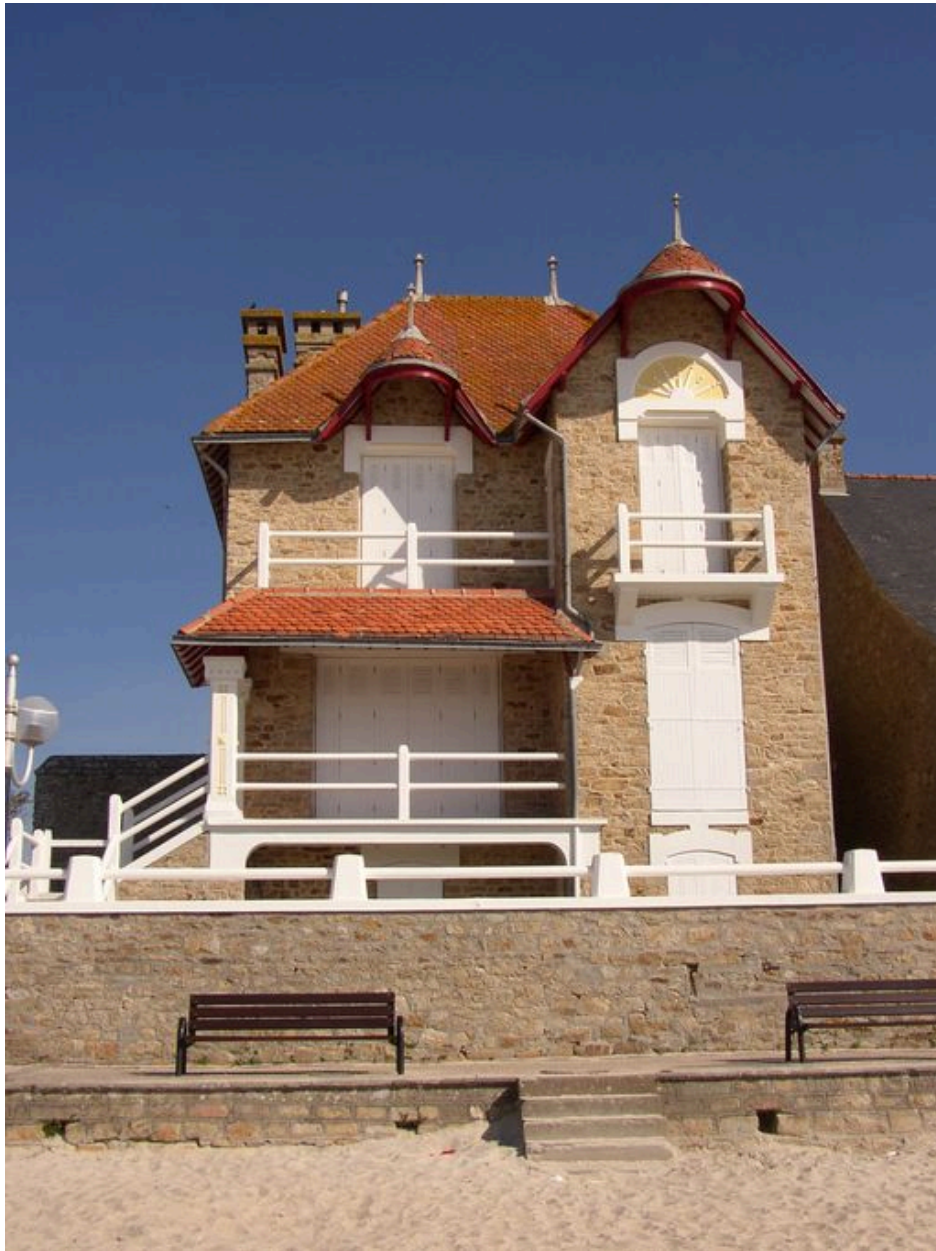
Vue générale de la maison de villégiature anciennement Ker Mat Jeanne
