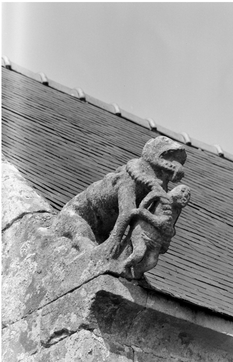
Croisillon sud : détail de la pierre d'assise sculptée du rampant est
