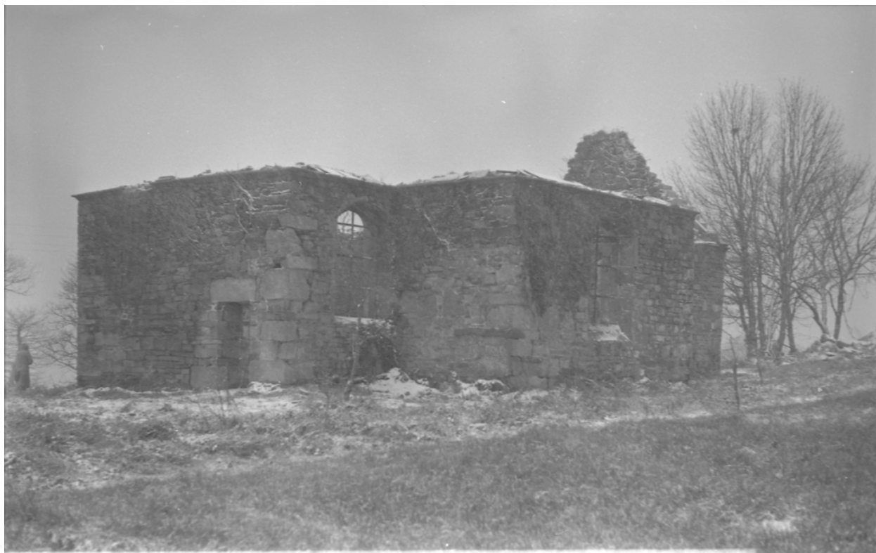
Vue générale prise du nord est
