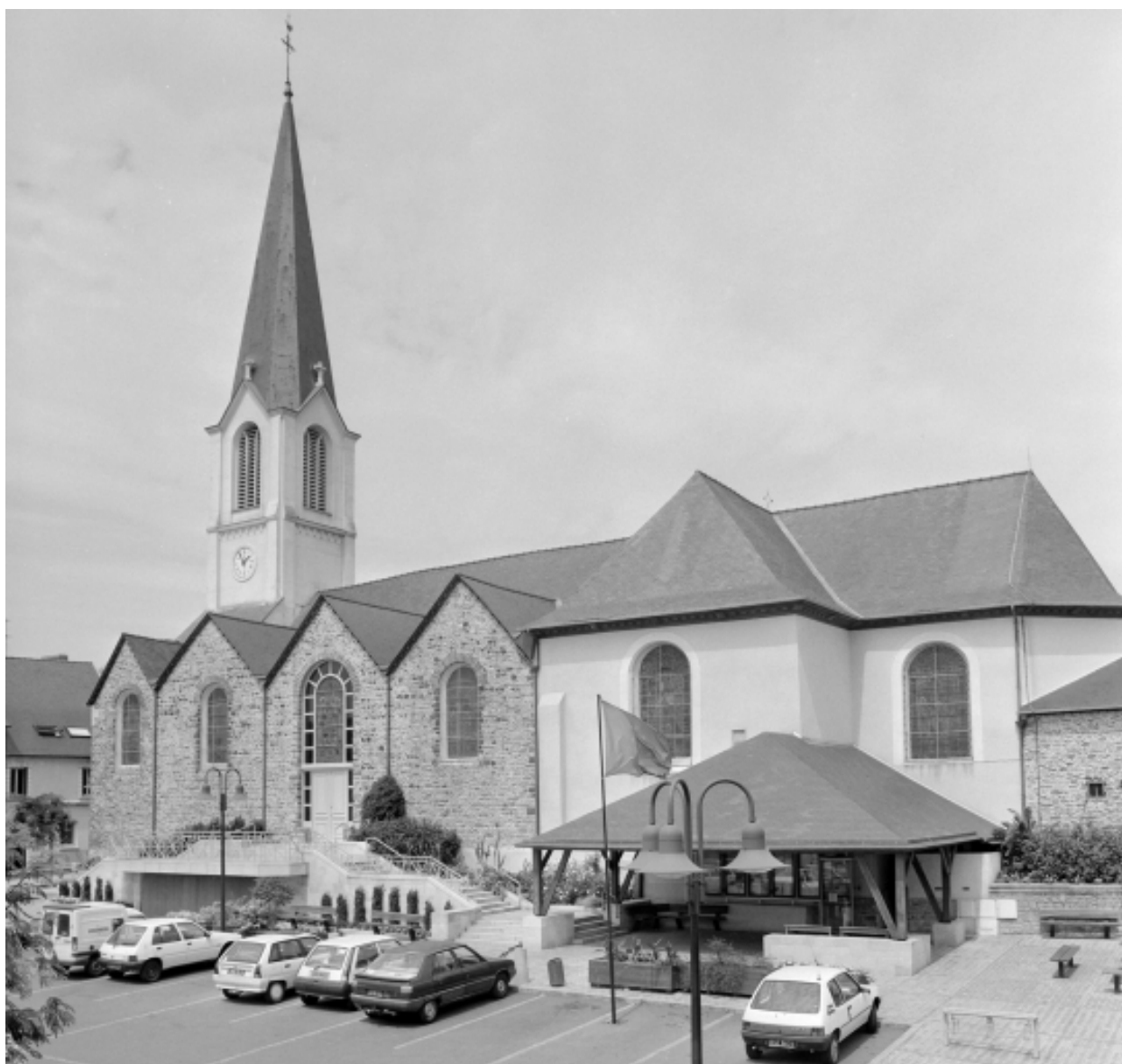
Elévation sud-est : vue générale
