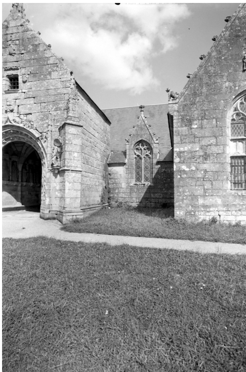
Vue extérieure de l'angle nord est du porche
