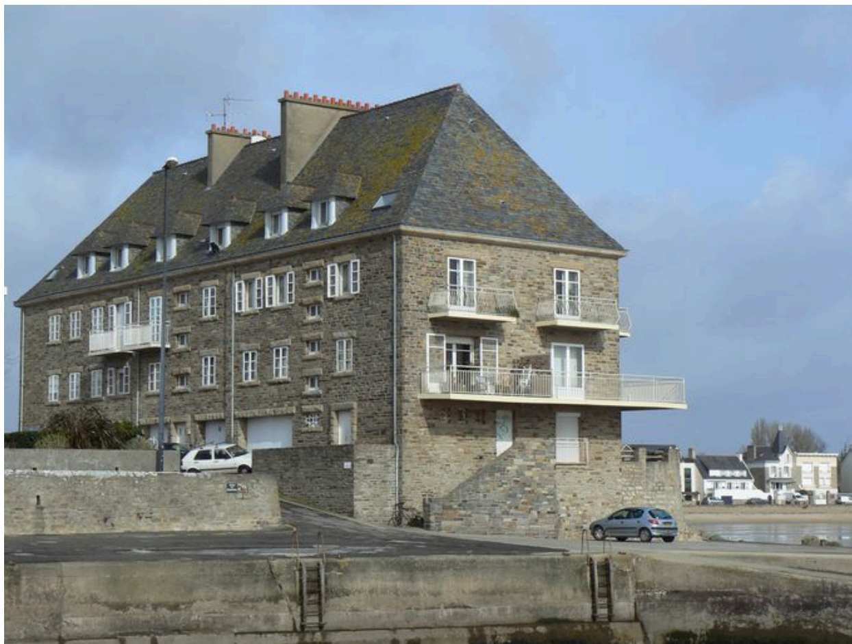
Immeuble Les Marines
