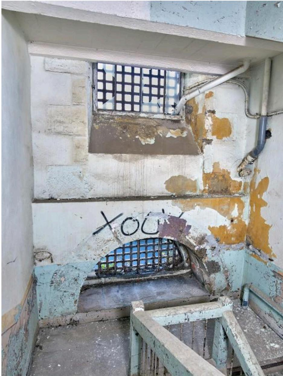
Vue du palier situé entre le rez-de-chaussée et le premier étage. L'escalier est en béton armé. Les baies ont perdu leurs carreaux en verre
