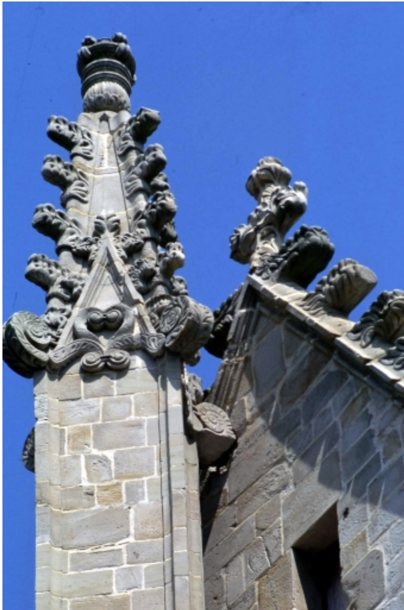
Elévation sud : détail pinacle.
