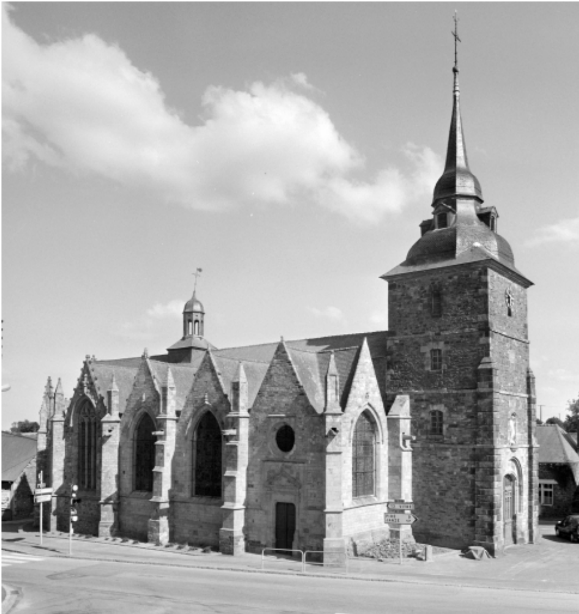
Elévation Nord-Ouest : vue générale
