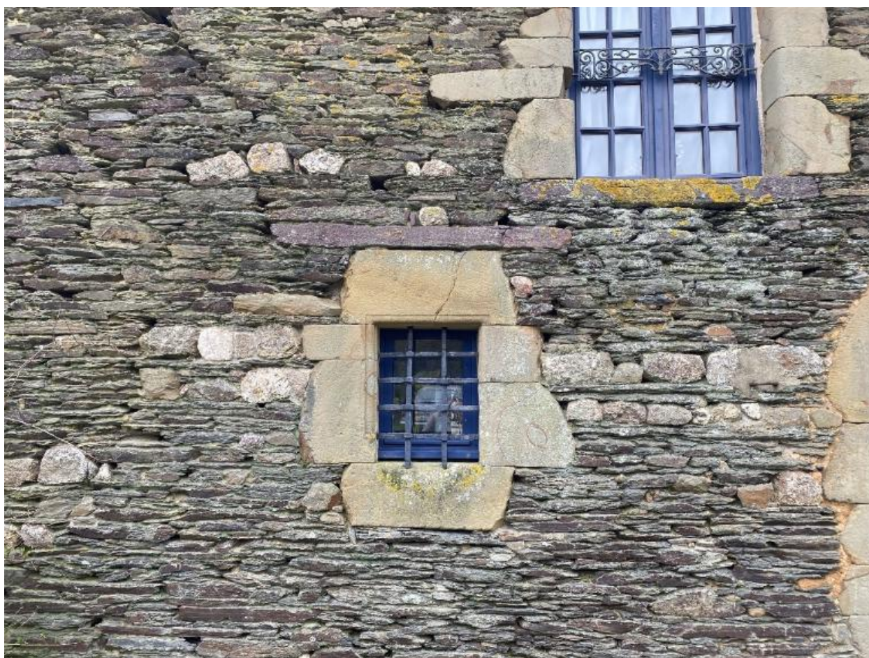
Aile nord, élévation sud, détail
