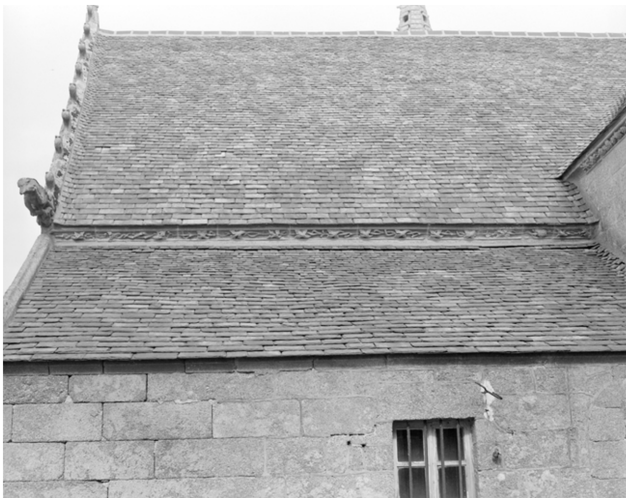
Transept, bras sud : corniche sur le mur est
