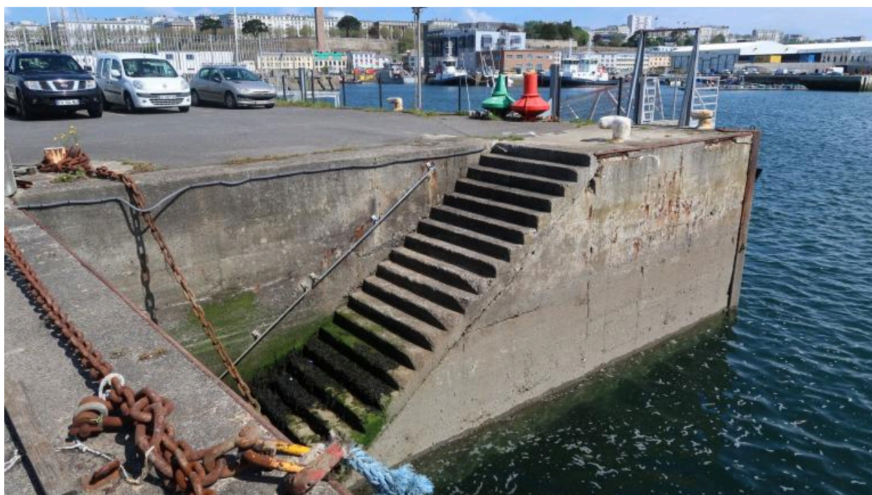
Quai des baliseurs, escaliers
