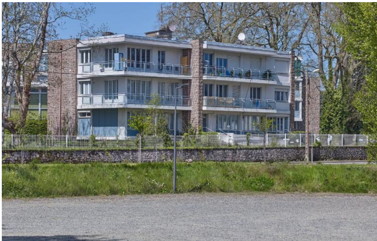
Vue d'ensemble des logements, prise du sud. R. Hummel, R. Rolland et A. Weinstein, architectes, 1961.
