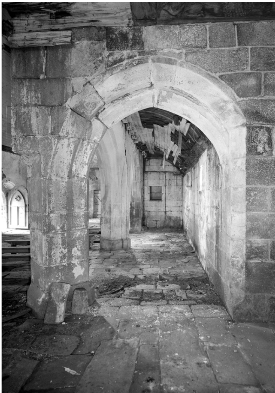
Bas-côté nord : vue d'est en ouest
