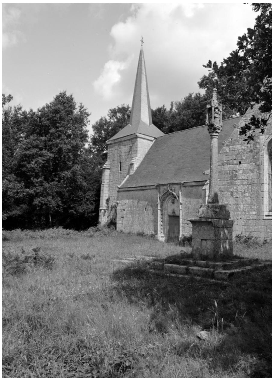
Vue de situation prise du sud-est
