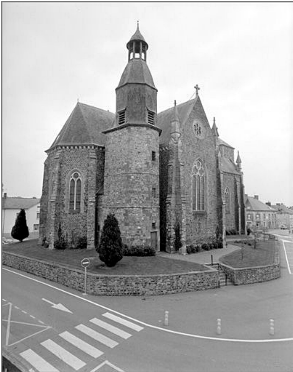
Elévation Sud-Ouest : vue générale
