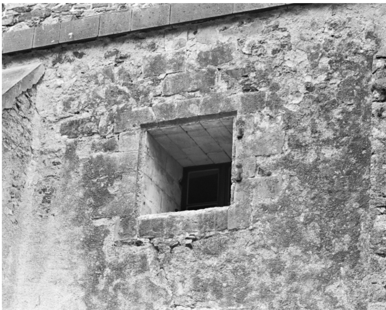
Vue du magasin à poudre : baie percée entre deux contreforts du mur sud (état en 1996)
