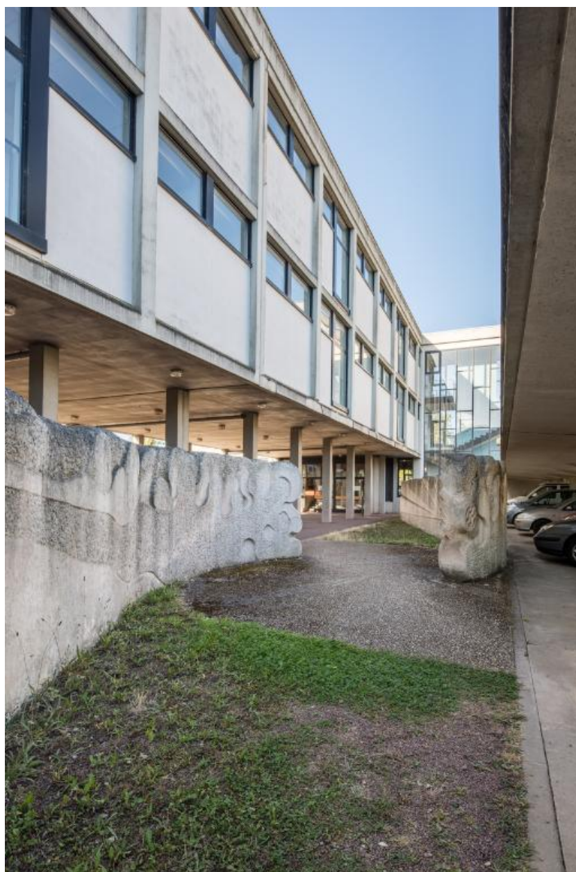
Sculpture de Yazuo Mizui (1976), en pierre de Vassens, formant brise-vent pour le préau (à gauche) et dallage d'accompagnement en galets. A gauche, abri à bicyclettes.
