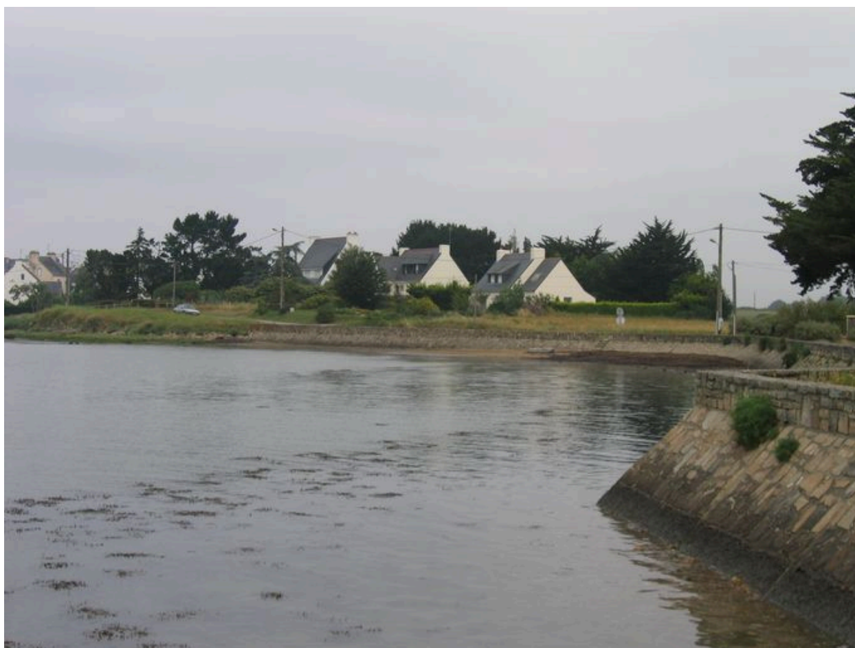
Digue de la Garenne
