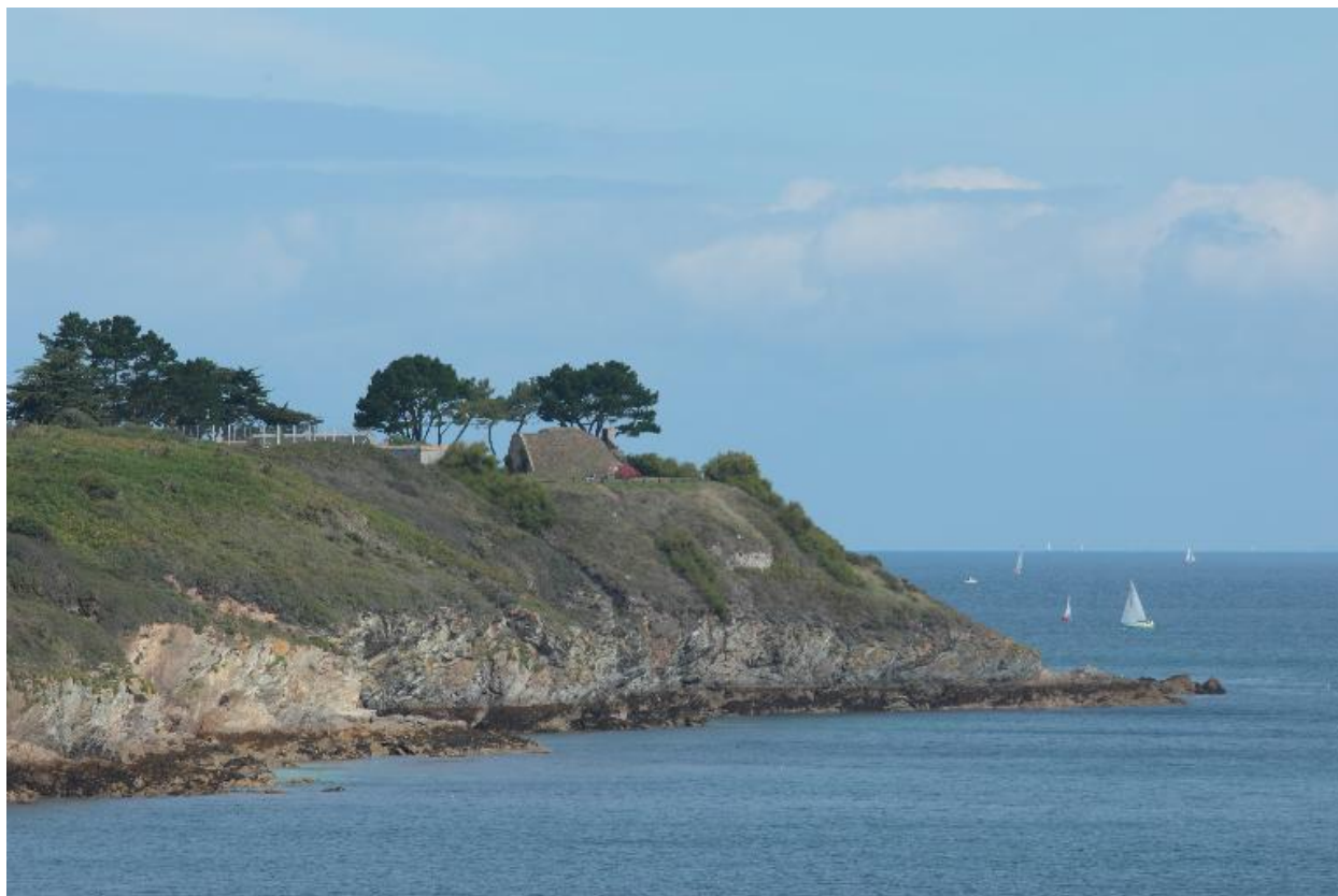
Le Palais, batterie de Ramonette, vue générale depuis le sud-est.
