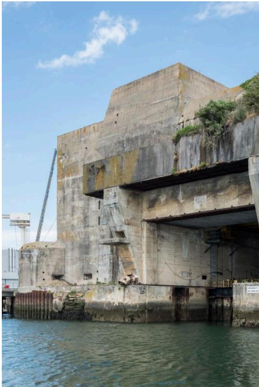
Vue de situation de la casemate pour quatre mitrailleuses flanquant l'angle ouest du bunker "KIII". Cet angle est surmonté par un encuvement pour canon antiaérien. A droite, alvéole A
