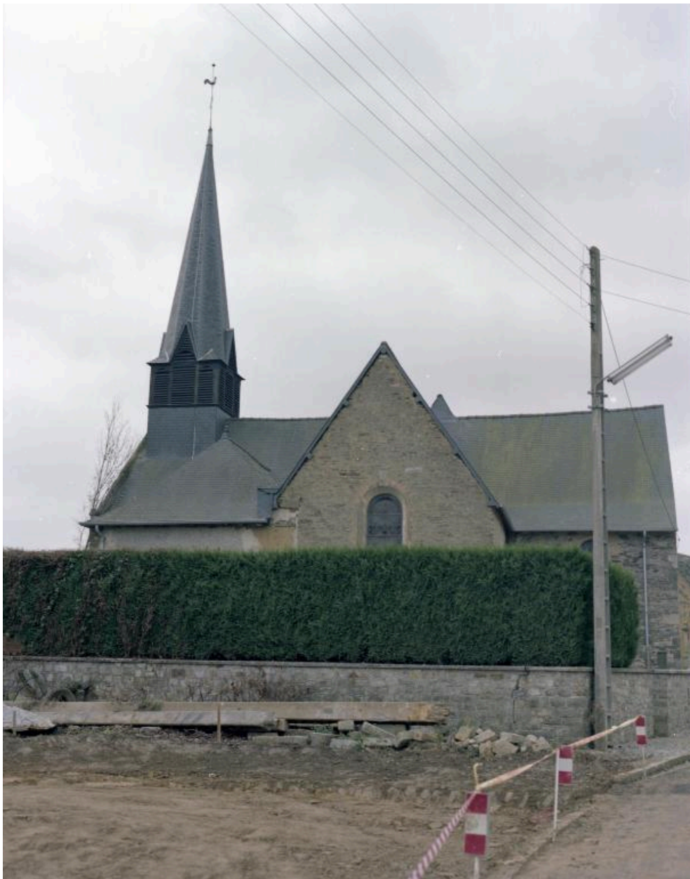
Façade latérale, vers 1980
