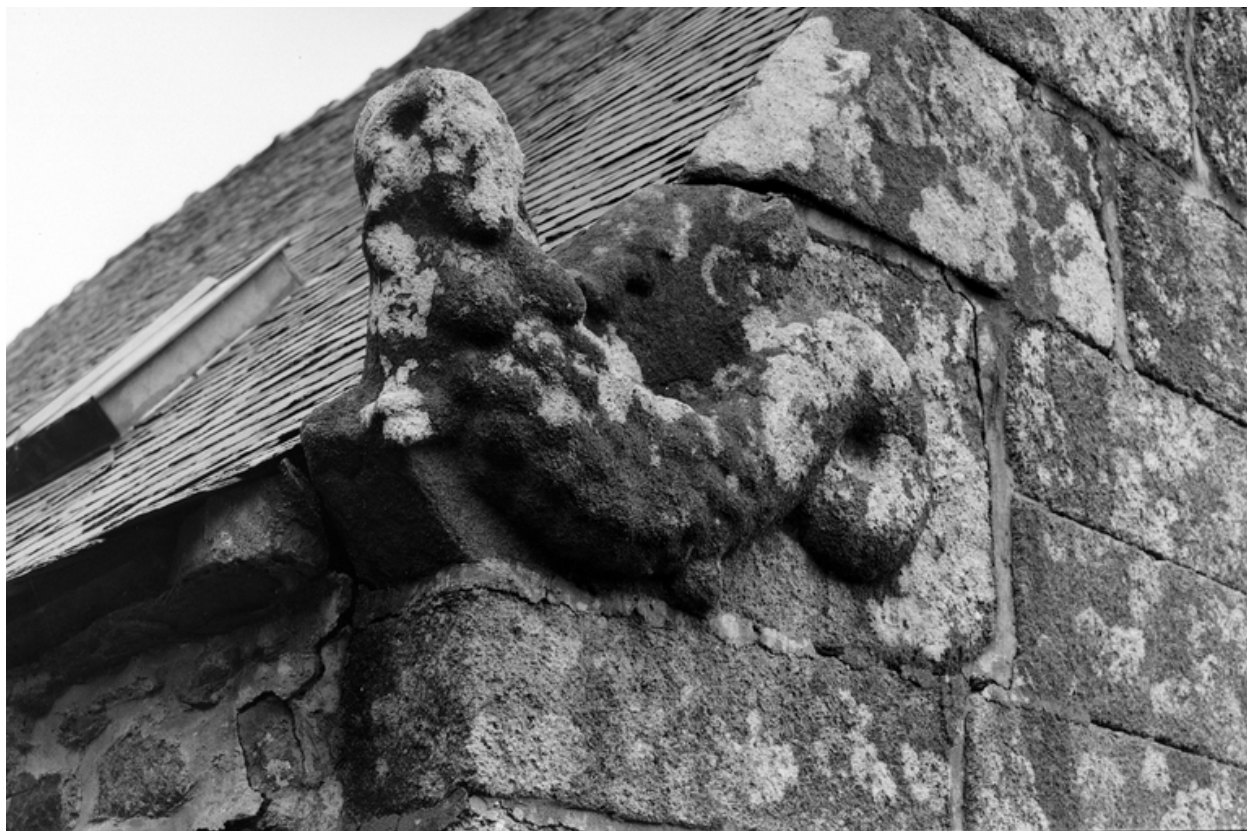
Chevet, détail : pierre d'assise nord du rampant
