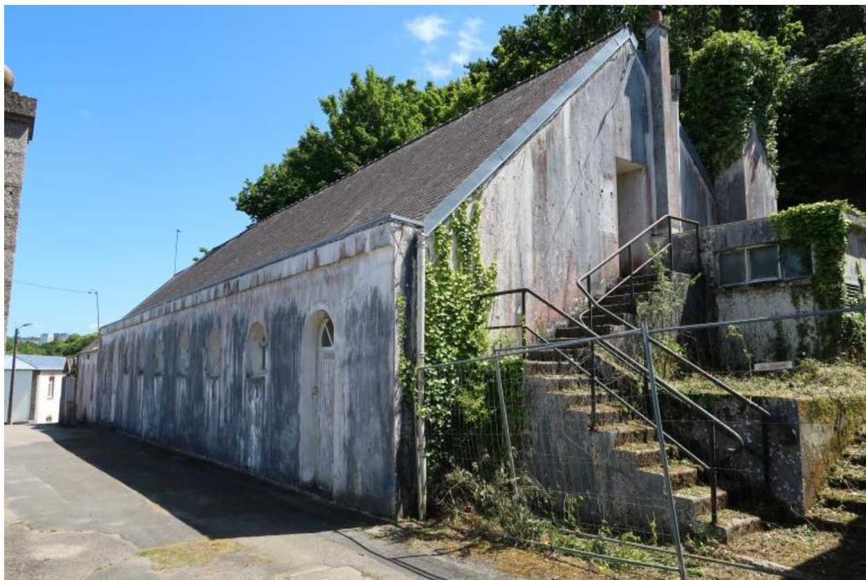
Vue générale : élévation nord (état en 2022)
