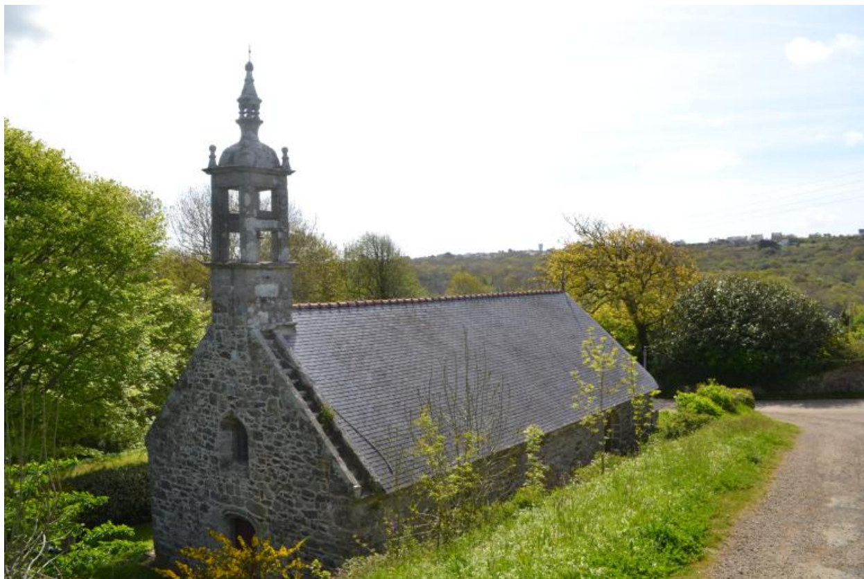
Vue générale prise du nord-ouest, clocher. (2018)
