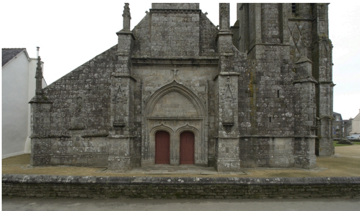
Vue partielle du massif occidental, portes jumelées
