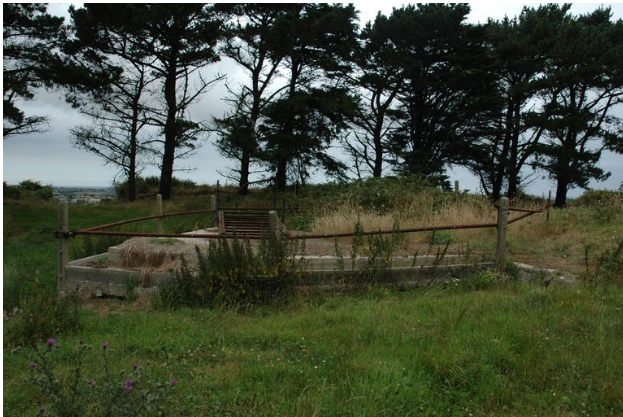
Vue de l'un des bunkers (état en 2002)
