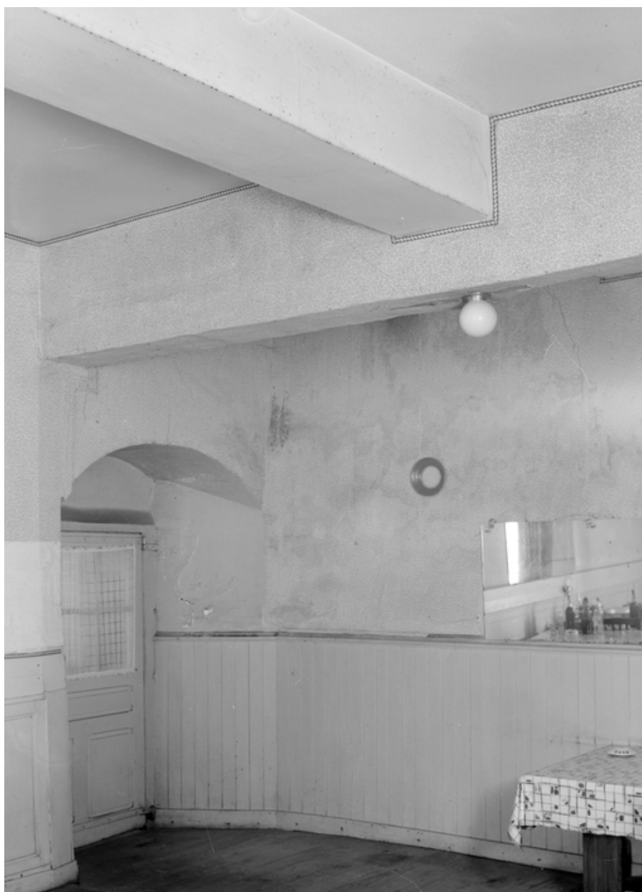
Porte et plafond dans l'angle nord-est de la pièce 2.
