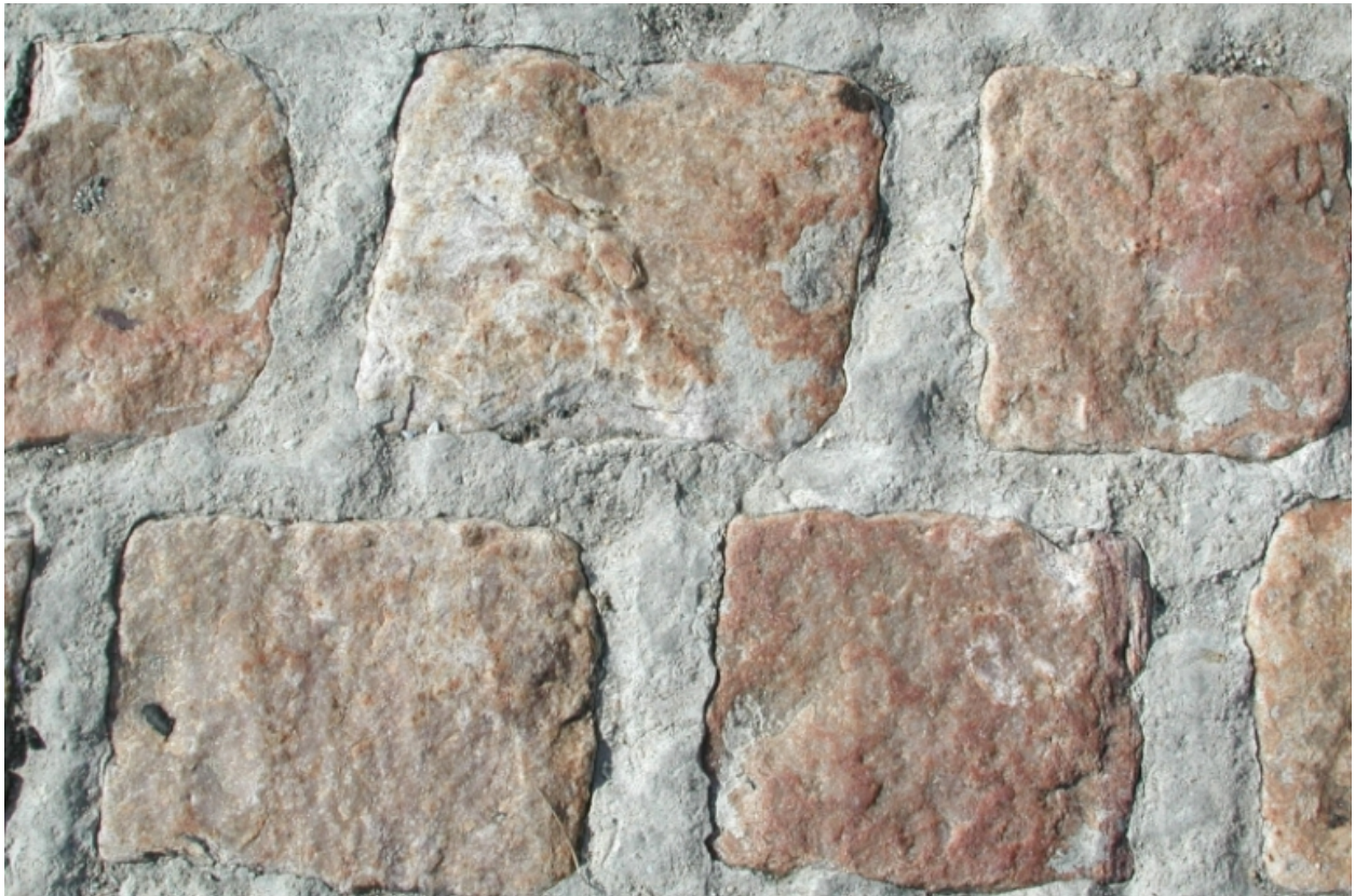
Détail des pavés de grès de parement, recouvrant la cale Hourdin (cale d'En Haut)
