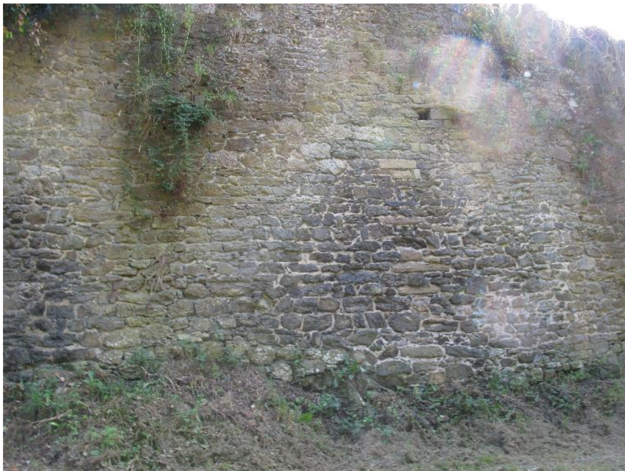
Château de Montafilan, enceinte nord
