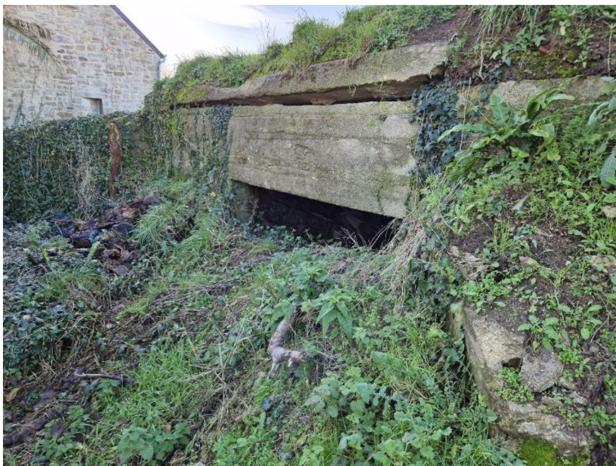
Vue générale (dalle de couverture). Le bunker est intégré dans la digue de Lannévez
