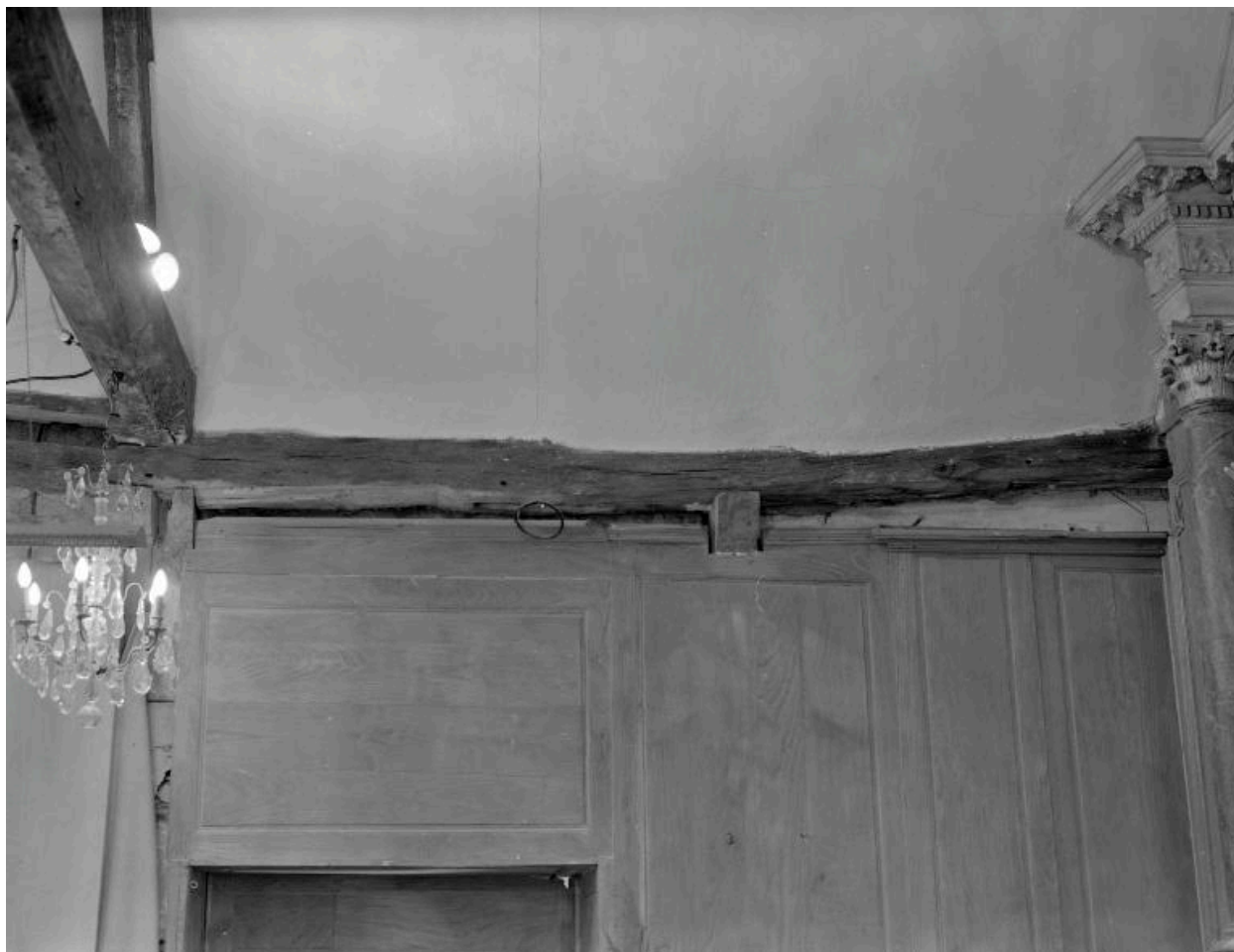
Vue intérieure, sablières et lambris du choeur, état vers 1980
