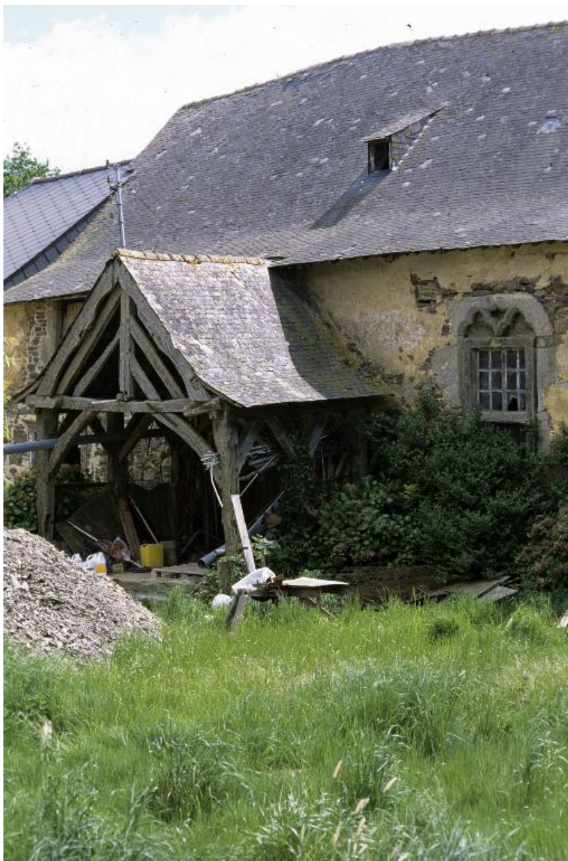
Elévation sud : vue rapprochée du porche.
