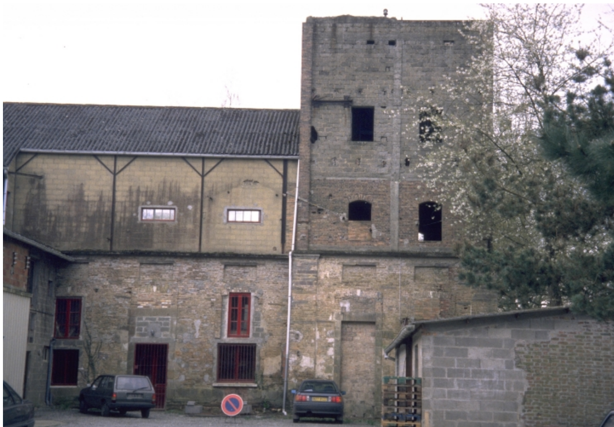
Atelier de fabrication et bâtiment de la colonne de distillation, façade nord. L'édifice a été très remanié.
