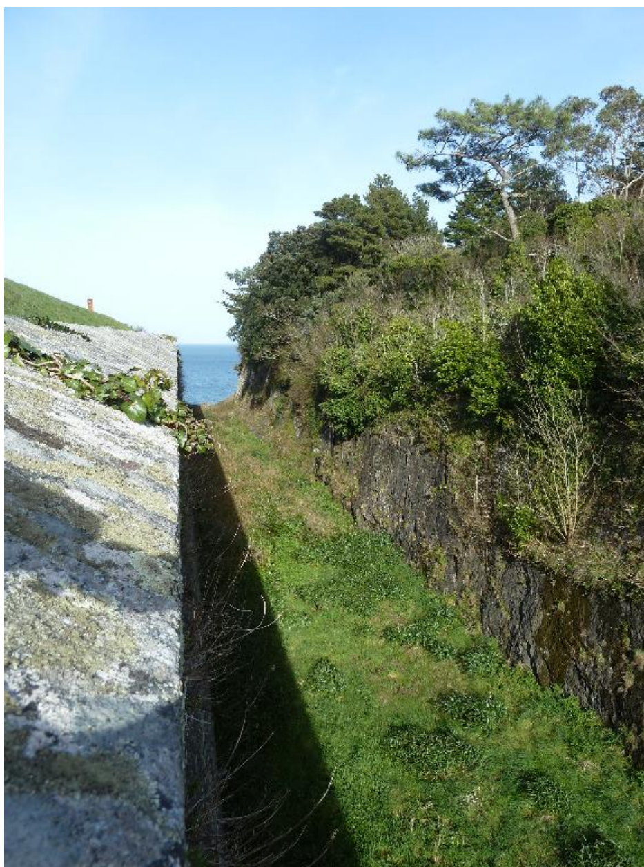
Le Palais, enceinte urbaine, courtine 18, fossé et contrescarpe.
