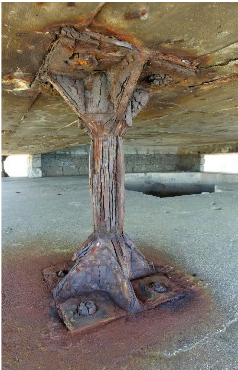
Vue du poteau métallique supportant la dalle de couverture de l'observatoire du bunker - poste de direction de tir de type M162a
