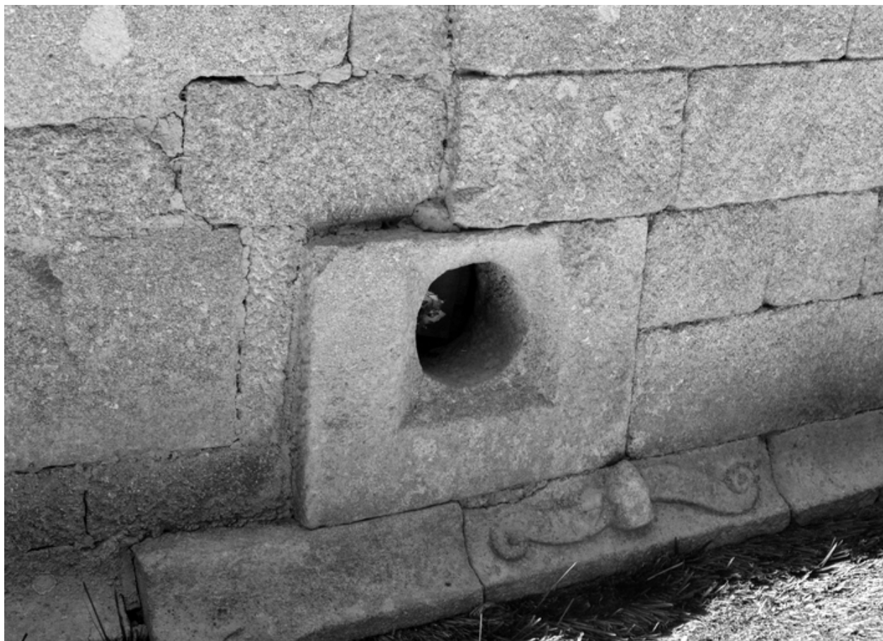
Détail de la façade.
